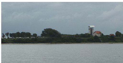
Augustenhof fyr renoveres.
