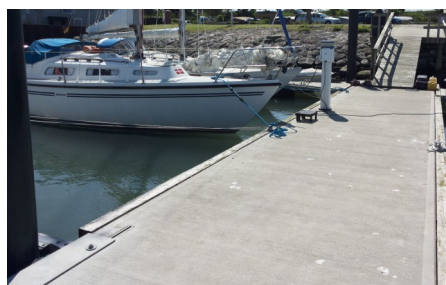
Mommark havn, fine broer, så når de sidste pæle er slået og der kommer et par fortøjningsklamper mere, så bliver det fint at lægge til :-)
